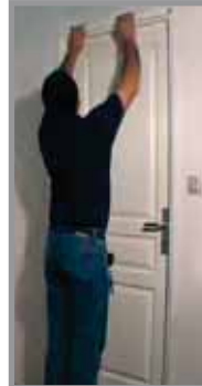
Pose des contre-chambranles et Pose des cache vis
